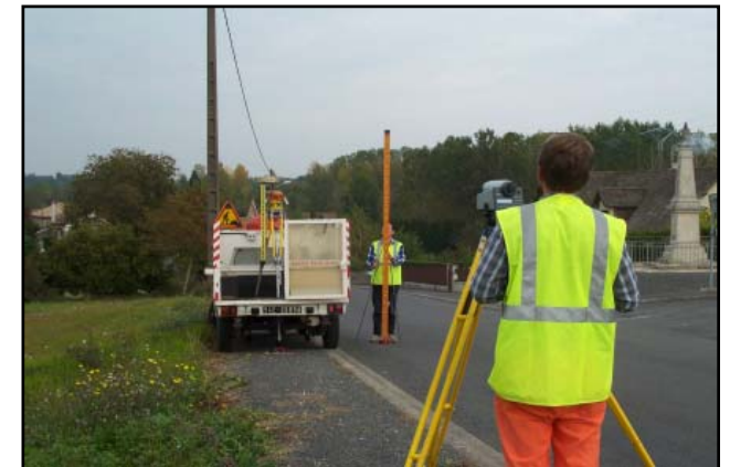
Nivellement de l'antenne
